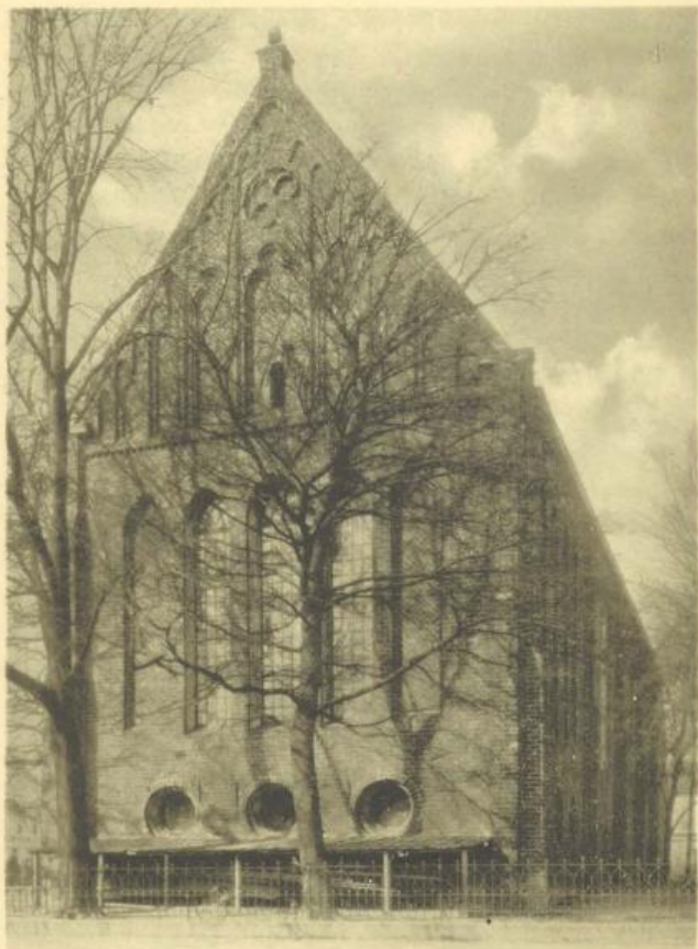
OOSTGEVEL DER KERK.
