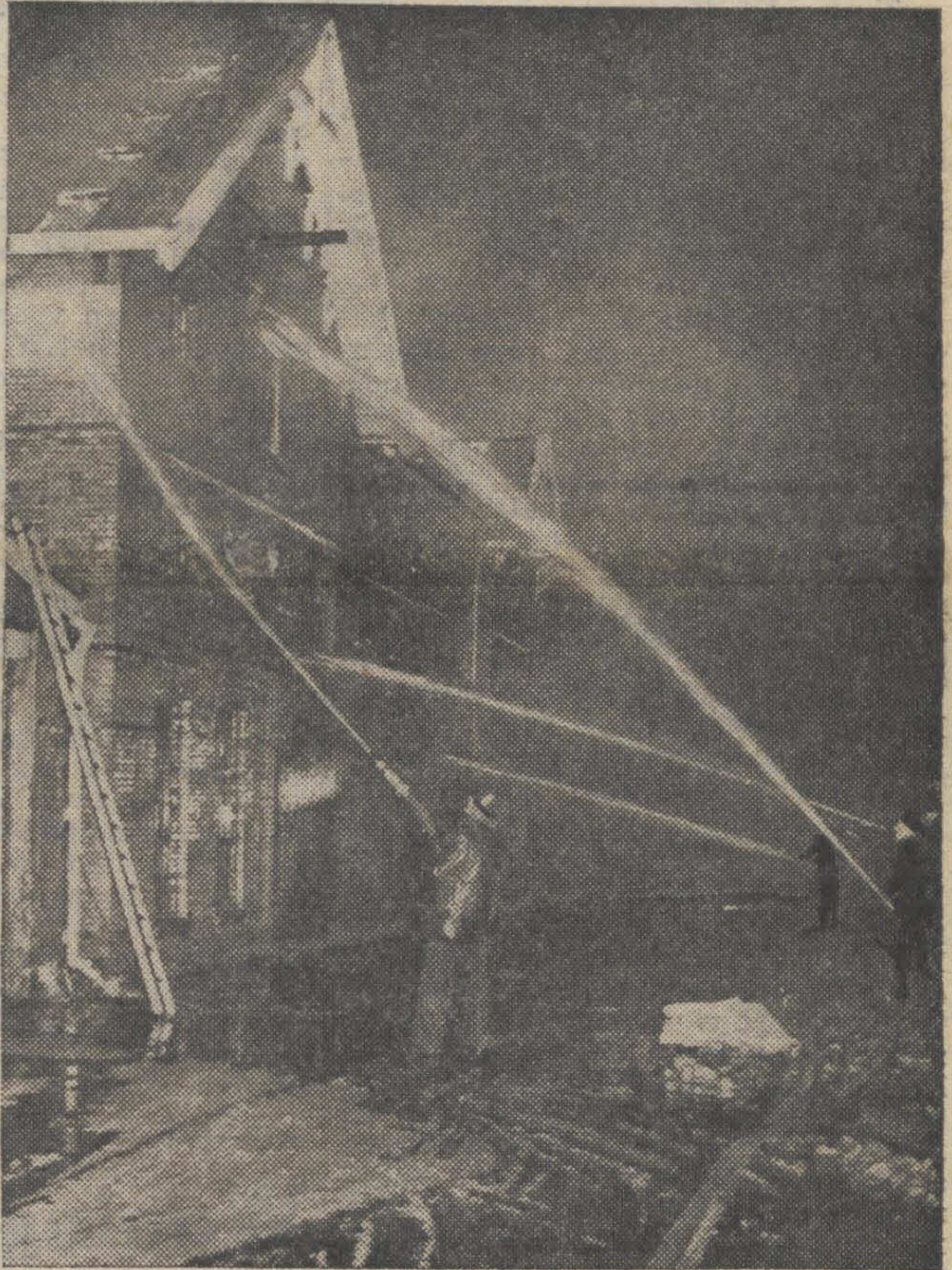
Hoewel de brandweer alles in het werk stelde om het vuur te beperken, kon zij niet verhinderen, dat het fabrieksgebouw van de fa v.h. H. Plas en Zn grotendeels verwoest werd.
